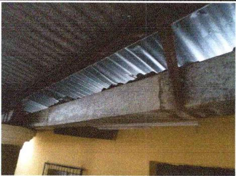
FOTOGRAFIA 5. SE PROPONE CAMBIO DE CANAL PLUVIAL
