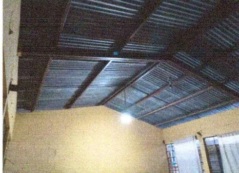
FOTOGRAFIA 2. SE PROPONE CAMBIAR CAMBIAR TECHO POR LAMINA TROQUELADA Y MANTENIMIENTO DE ESTRUCTURA METALICA
